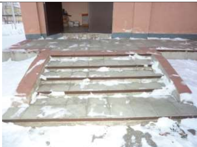
№ 16, запасной выход №3, лестница
