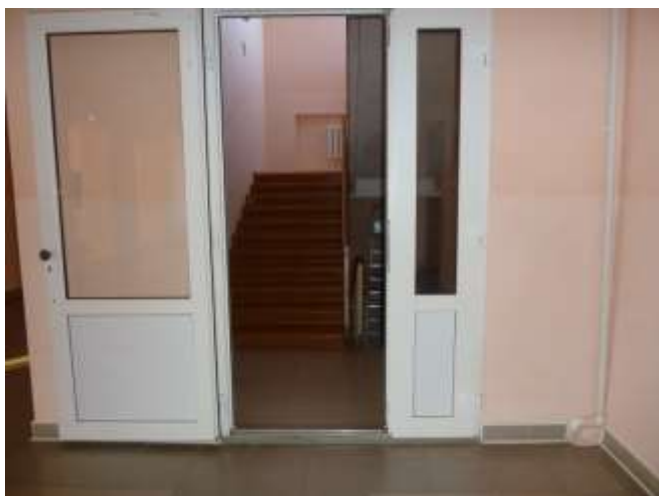
№ 29, эвакуационный путь, 1 этаж
