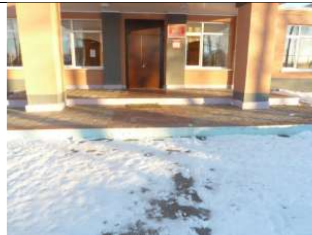
Фото №10, площадка перед дверью
