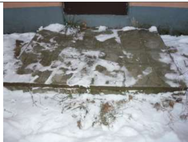
№ 17, запасной выход №6, лестница
