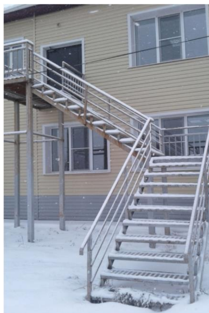
фото № 6 запасной выход (2) со 2 этажа
